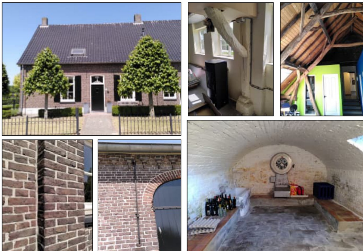
Figuur 14: Foto's langgevelboerderij in de huidige staat (Bron: Cultuurhistorische verkenning, Maikel Niël Bouwhistorie)
