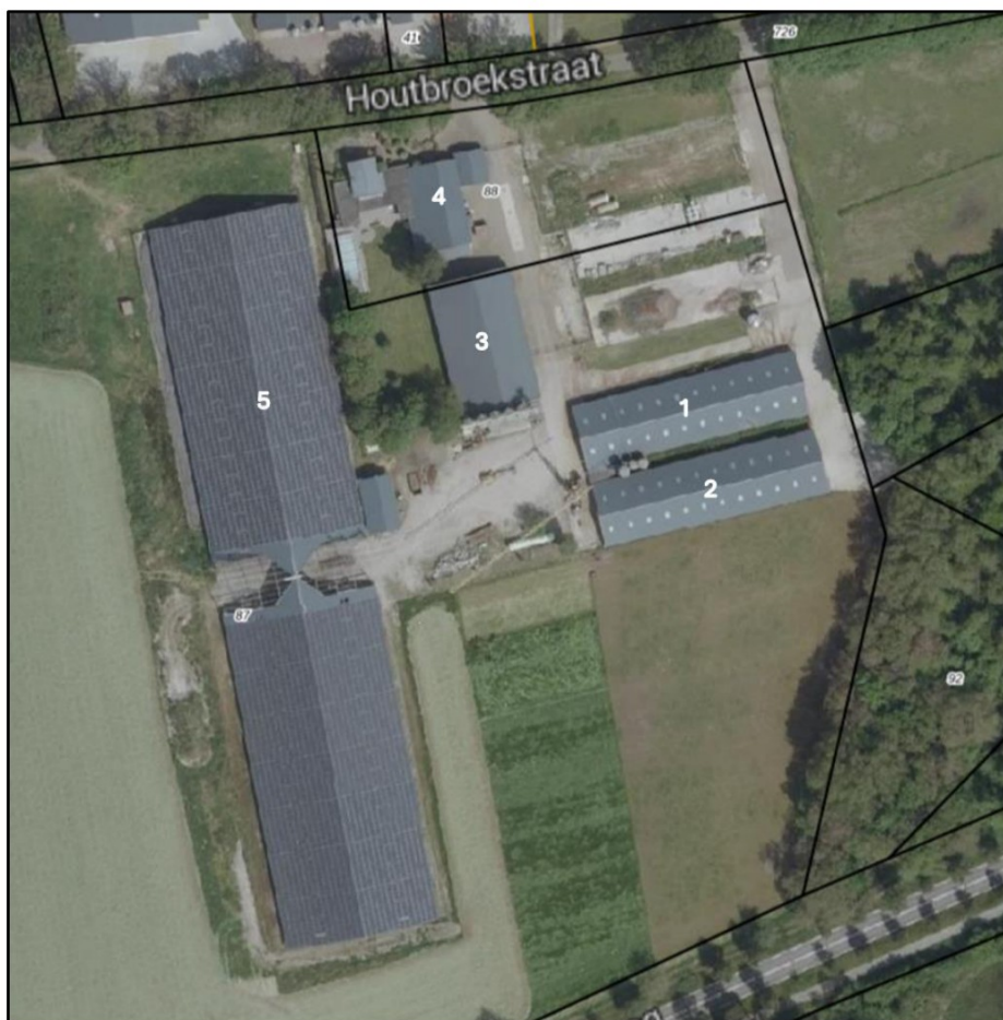
Afbeelding 3 Luchtfoto huidige situatie plangebied
