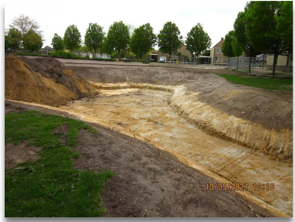
Figuur 4.3 Aanleg wadi in 2021 (Foto: Gemeente Someren)
