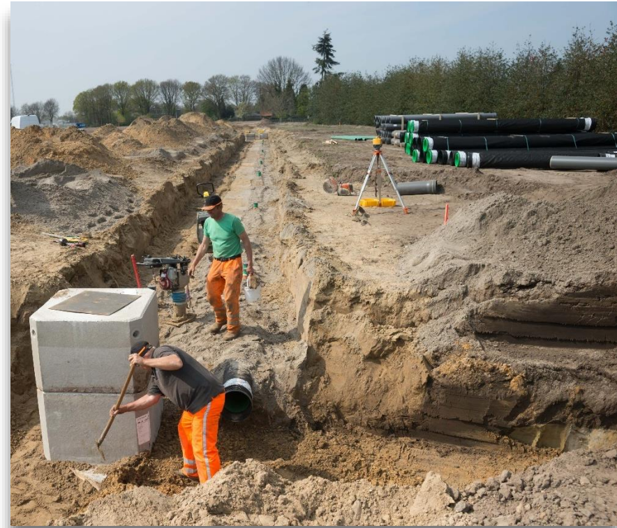
Figuur 5.3 Aanleg van nieuwe riolering in 2019 (Foto: Gemeente Someren)
