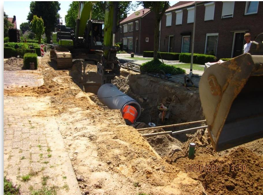
Figuur 2.1 Riolvervanging in 2021 (Foto: Gemeente Someren)
