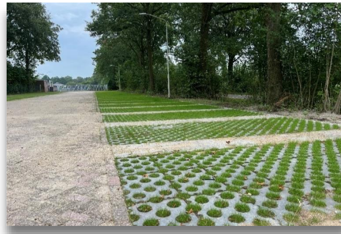
Figuur 5.1 Grasbetontegels in Bennenbroekstraat
