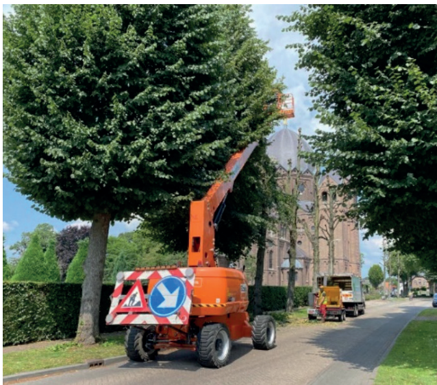
Werkzaamheden aan de Somerenseweg in Lierop
