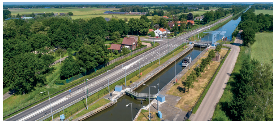
Sluis 13 in de Zuid-Willemsvaart bij Someren. Ernaast ligt de provinciale weg N266. (Fotograaf: Paul van Baardwijk - Studio Retouched)
